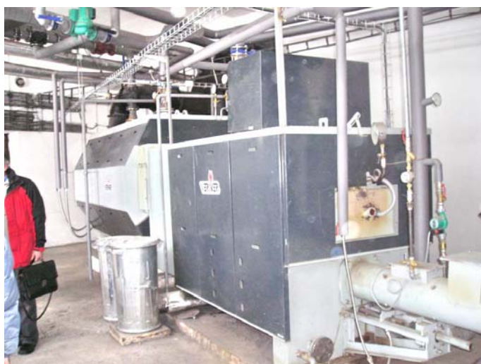
Obr. 5 Kotol na drvenú slamu o výkone 600 kW
